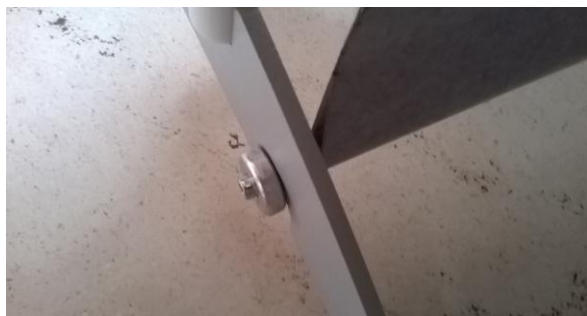
Primer panela na kojem je zavrtnanj olabavljen i počinje da izlazi iz panela.
